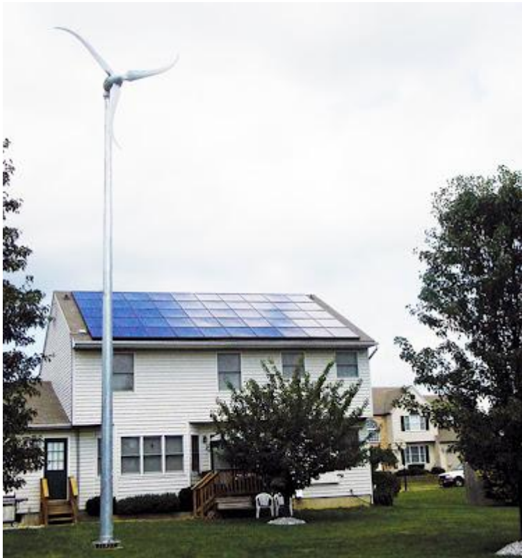
[Εικόνα 2] Ανεμογεννήτρια οριζόντιου άξονα περιστροφής τοποθετημένη σε εξωτερικό χώρο της κατοικίας
