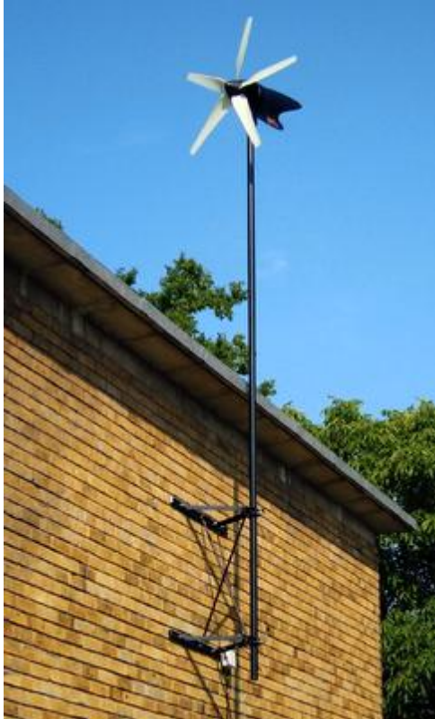
[Εικόνα 1] Ανεμογεννήτρια ονομαστικής ισχύος 400 Watt ενσωματωμένη στο κέλυφος της κατασκευής
